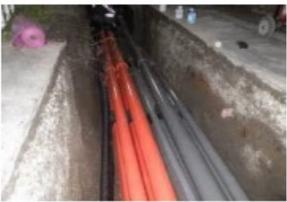
浅層埋設の事例 | 小型化したボックス内にケーブルを埋設<br>
