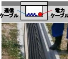
小型ボックスの事例 | 安価で弾性がある角型多条電線管を地下に埋設<br>
